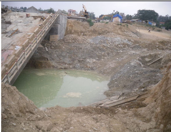
Hố móng trụ tạm
