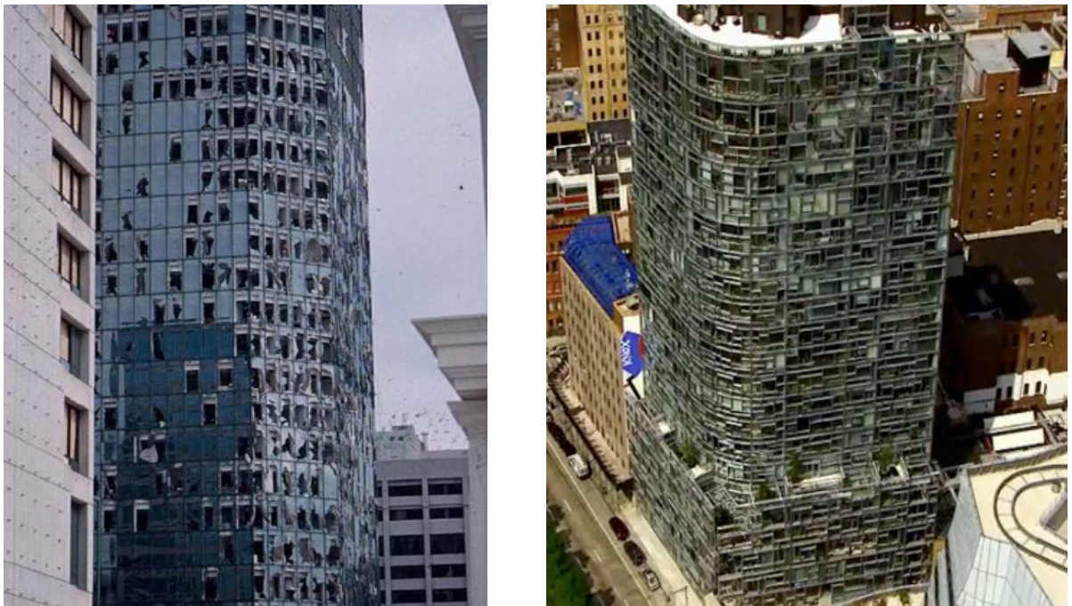
Hình 1. Hình ảnh một số phá hoại của mặt dựng nhôm kính do gió, bão
