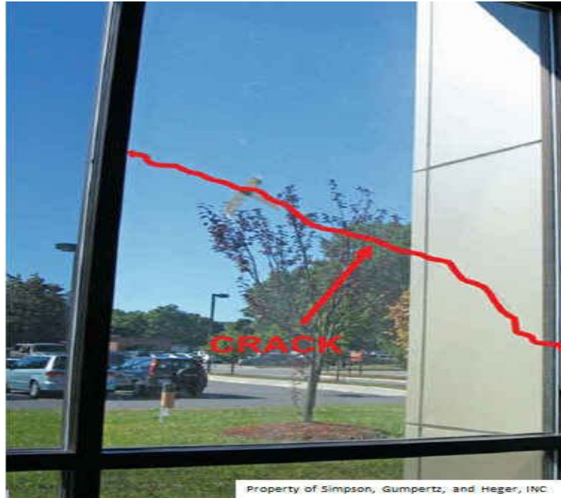
Hình 2. Vết nứt kính do tác động của nhiệt
