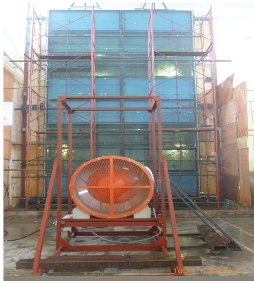
e) Thử nghiệm mặt dựng nhôm kính của Nhà điều hành Tổng công ty Cảng Hàng không Việt Nam (Hồ Chí Minh) [5]
