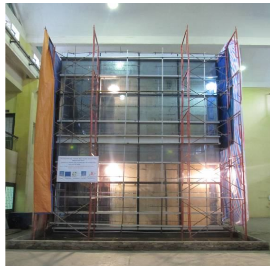
b) Thí nghiệm mặt dựng nhôm kính của công trình
